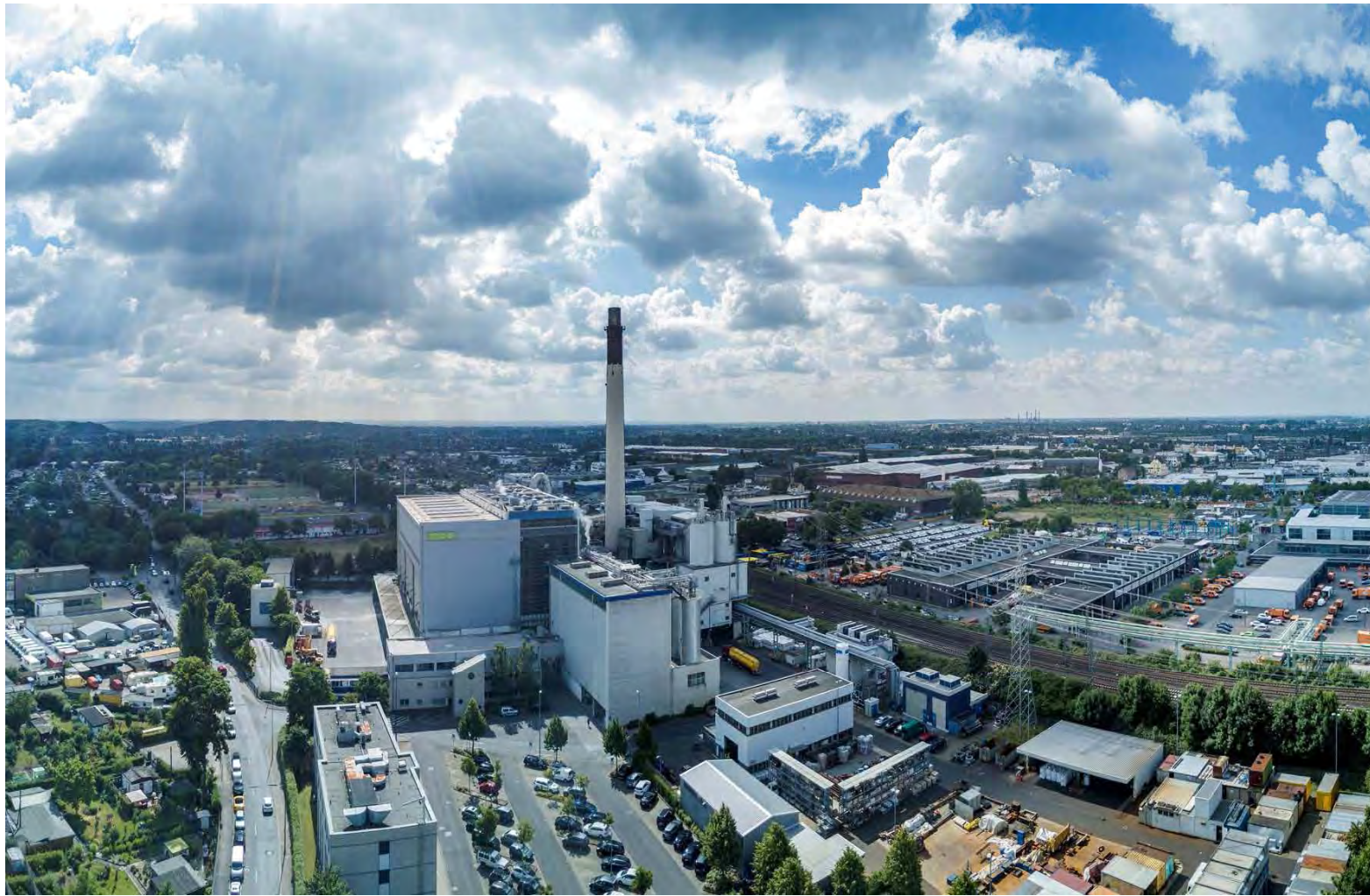
Müllverbrennungsanlage Flingern (Düsseldorf), Quelle: AWISTA Gesellschaft für Abfallwirtschaft und Stadtrei- nigung mbH
