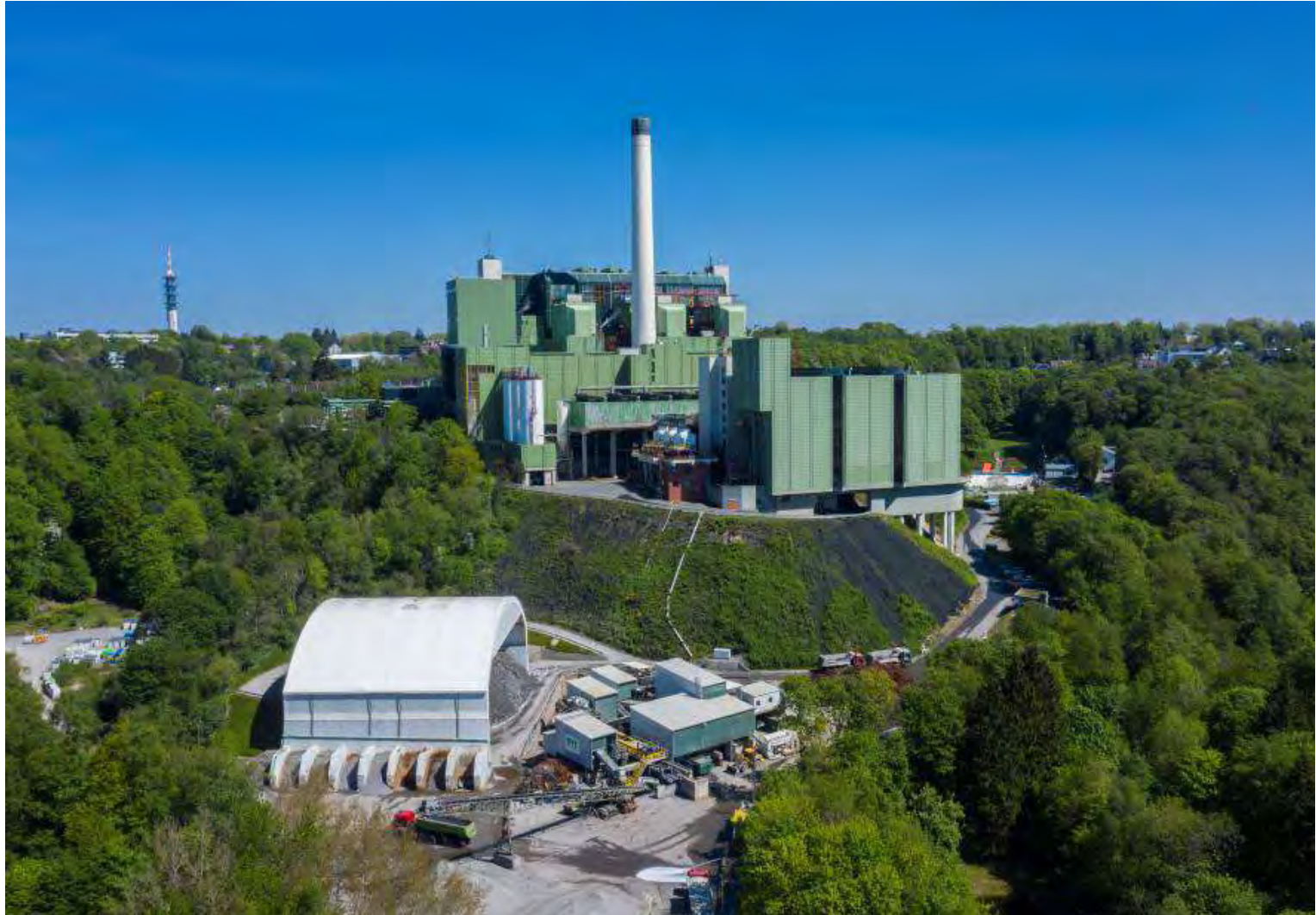
AWG Wuppertal, Gesamtansicht MHKW Wuppertal, Quelle: AWG Wuppertal
